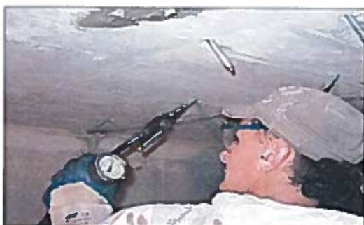
Инжектиране на стоманобетон с епоксидна смола за заздравяване на напукана конструкция. Използвана се еднокомпонентна помпа
