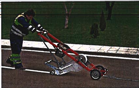
Полагане на светлоотразителна лента "STANMARK" върху пътни настилки
