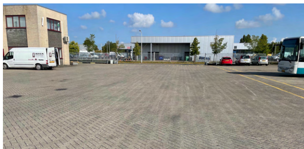
Ingang en ruimte voor opstelplaatsen
