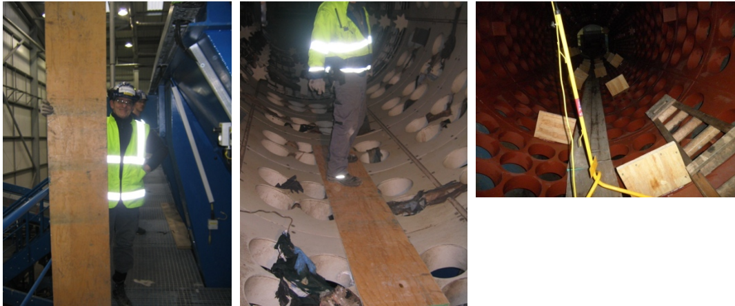
Фиг. 27: Покриване на пресевните ламарини и на съединенията и веслата
