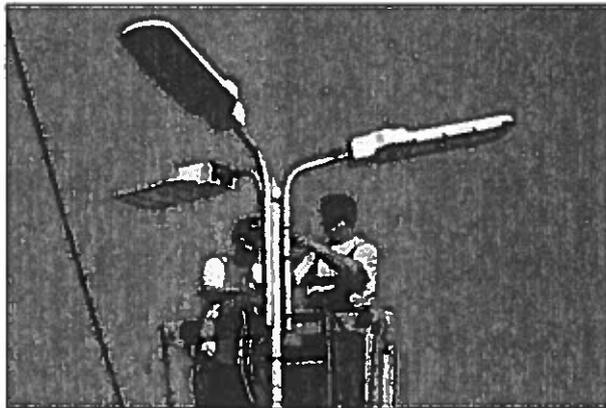
След свързването се подава напрежение за изпробване на изпълненото осветление.
