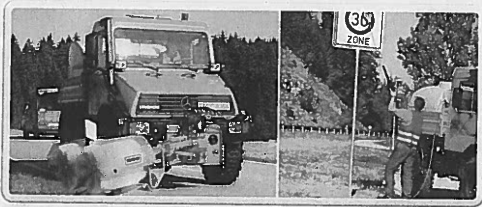
Примерна снимка – механизано почистване на пътни принадлежности
