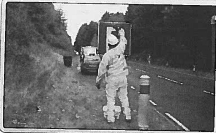
Примерна снимка – ръчно почистване на пътни принадлежности
